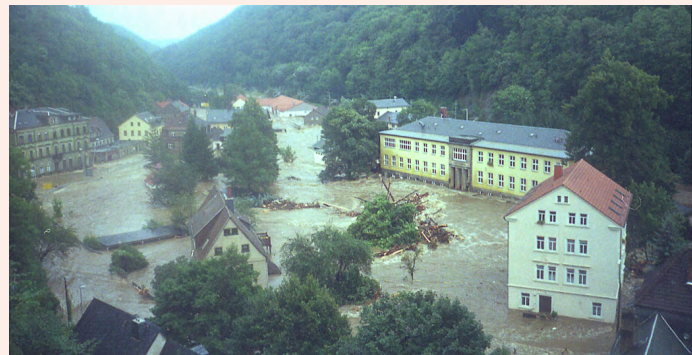
Campus der TU Dresden in Tharandt beim Hochwasser der Wilden Weißeritz am 13.08.2002. Foto: Heiko Prasse
